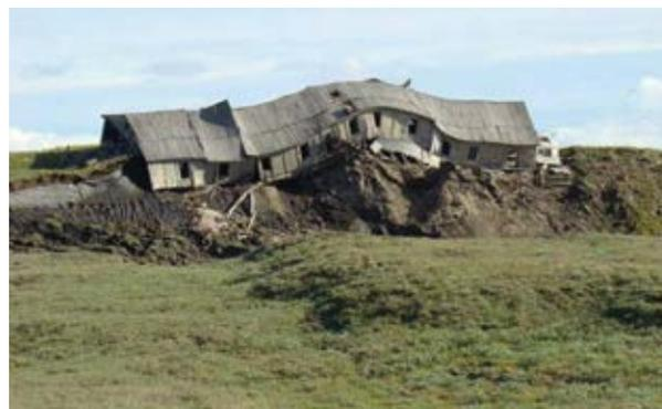
*A medida que el clima cambia y las temperaturas aumentan, el permafrost se derrite a niveles cada vez más profundos en el verano. La profundidad de los montones previamente construidos puede ser insuficiente haciendo que comiencen a “flotar”, provocando la deformación y el colapso de los edificios.*
